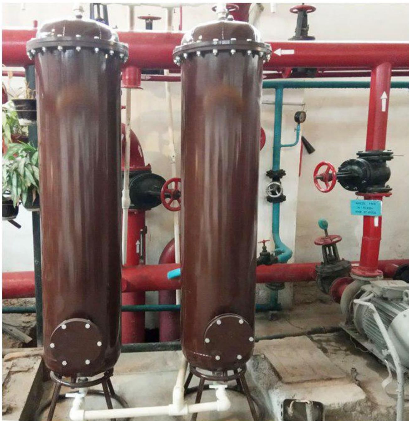
В отличие от зарубежных аналогов учеными Института используется новая технология модифицирования сильнокислотного катионита наночастицами серебра, что позволяет не только придать ему бактерицидные свойства, но и выполнять функцию удаления растворенного кислорода из воды. В настоящее время разработанные системы химводоподготовки успешно внедряются в Узбекистане, в т.ч. на объектах ГП «НГМК», ГУП «Toshisshiqquvvati» и пр.
